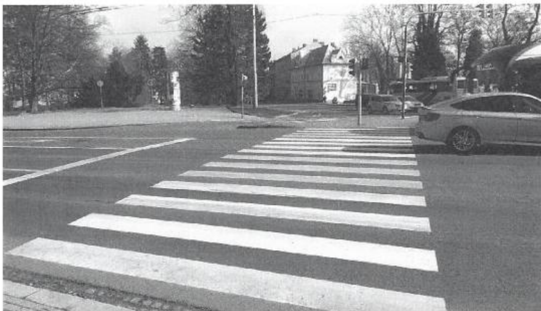
Pohled na řešený ostrůvek – bude zřízen sdružený přechod a přejezd, včetně doplnění reliéfní dlažby v ostrůvku a na okrajích vozovky, doplněny vodící pásy přechodů. Pochozí a nepochozí plochy budou odděleny výškově 1 barvou.
