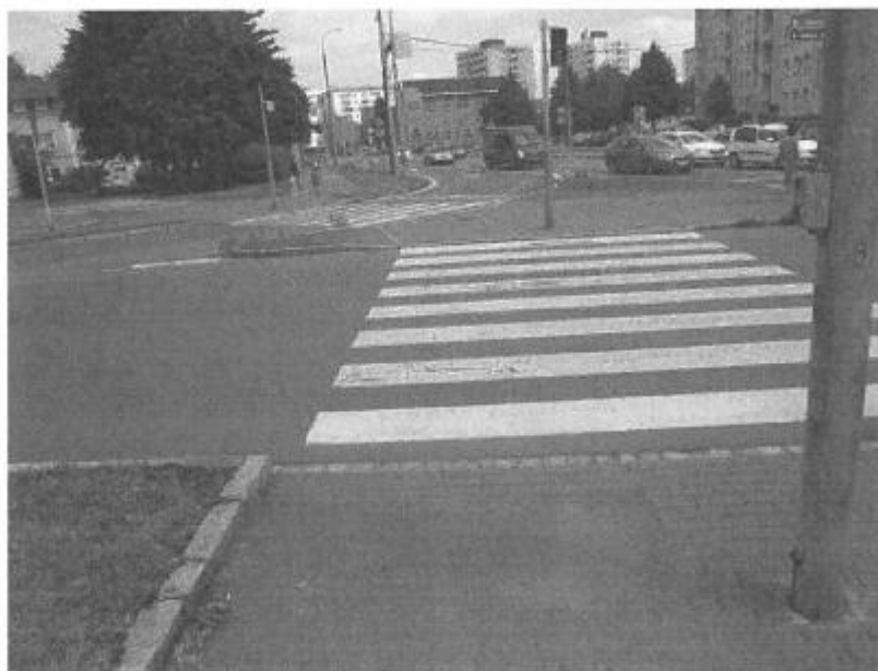
Pohled na řešený ostrůvek – bude doplněna reliéfní dlažba v ostrůvku a na okrajích vozovky, doplněny vodící pásy přechodů. Pochozí a nepochozí plochy budou odděleny výškově i barvou.
