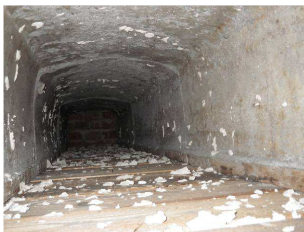
Foto č. 9 a 10 – pohled do dutin žebírkového stropu – sonda NV 8
