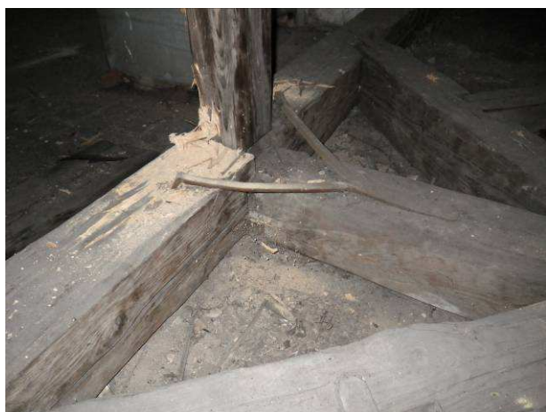
Foto č. 4 a 5 – spoje vazných trámů a spodní část sloupku – pozice 12'C
