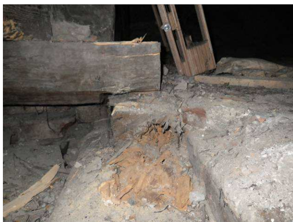
Foto č. 4 a 5 – spoje vazných trámů a spodní část sloupku – pozice 12'C
