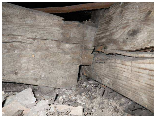
Foto č. 8 – ohořelé prvky krovu – pozice 6 A - C
