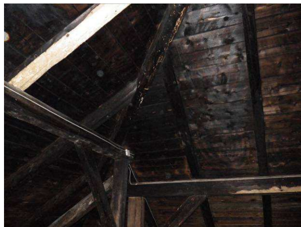
Foto č. 8 – ohořelé prvky krovu – pozice 6 A - C
