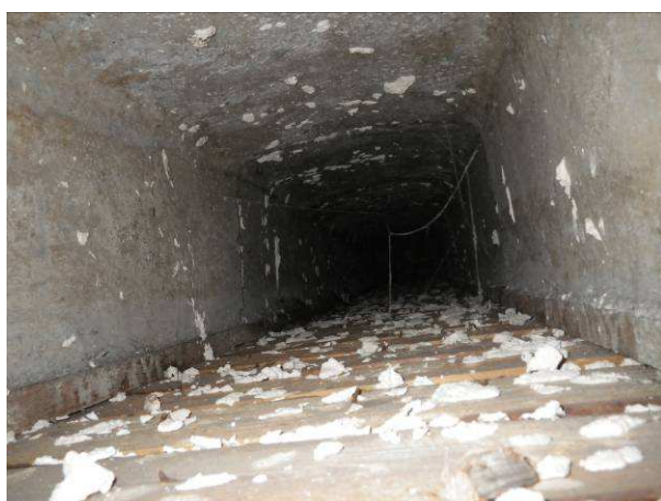
Foto č. 9 a 10 – pohled do dutin žebírkového stropu – sonda NV 8
