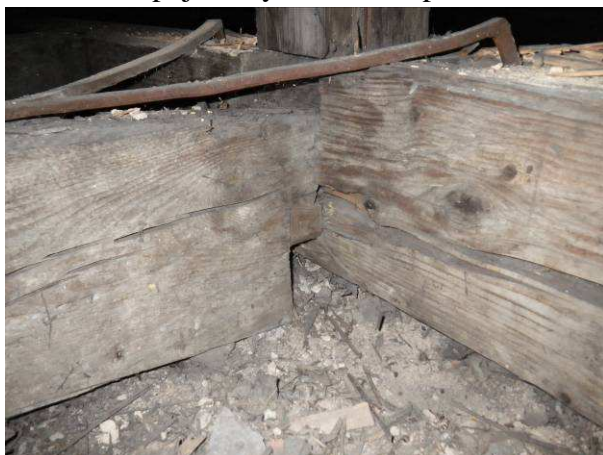
Foto č. 6 a 7 – spoj vazných trámů – pozice 12°C
