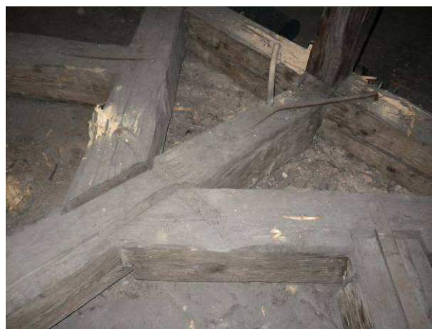
Foto č. 4 a 5 – spoje vazných trámů a spodní část sloupku – pozice 12'C
