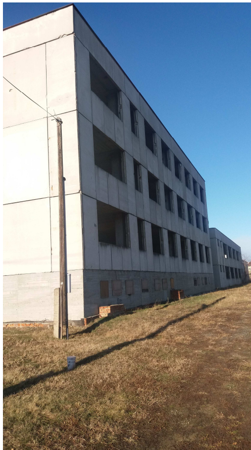
POHLED NA VÝCHODNÍ FASÁDU
