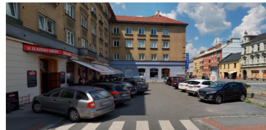
PARKOVIŠTĚ (NEVYHOVUJÍCÍ „ŽIVELNÉ“ PARKOVÁNÍ) NA ASFALTOVÉ PLOŠE
