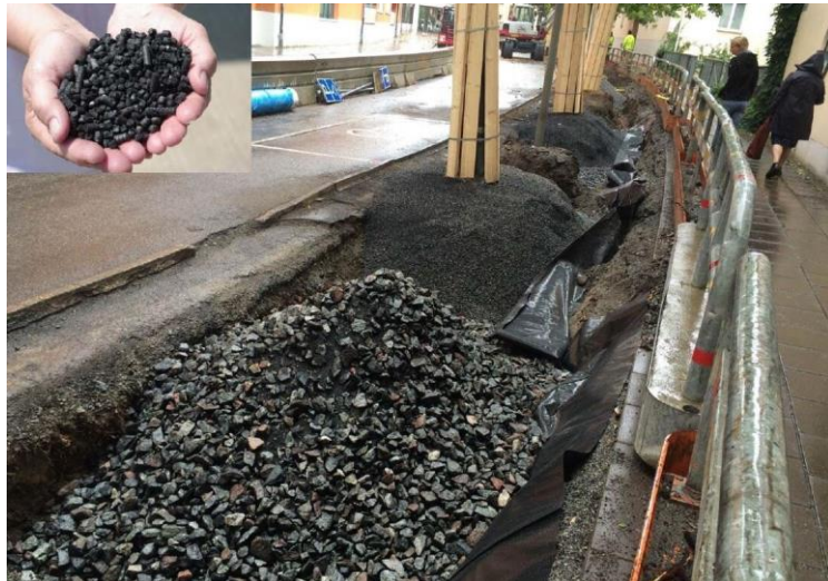
Strukturální substrát (drcené kamenivo nevápenaté 36/60 mm, biouhel, kompost)
