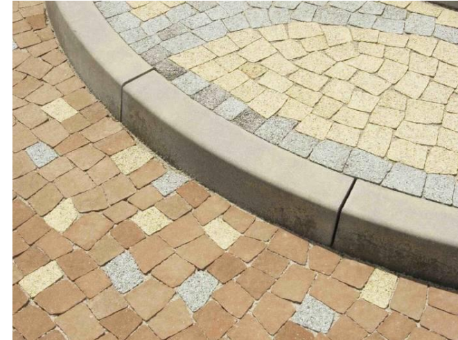
Betonový silniční obrubník rovný 1 m, a obloukový R 2 m
