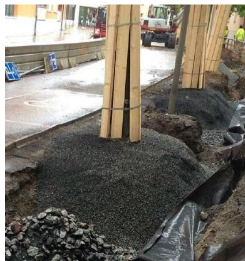
Minerální substrát (ornice, drcené kamenivo 4/8 + 8/16 mm, kompost, hydrogel)
