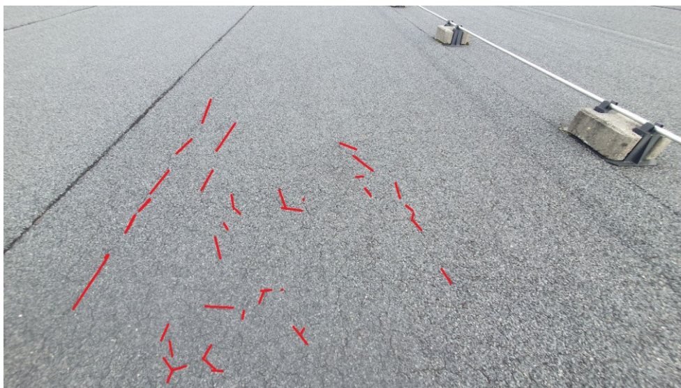
Obrázek č. 8 – popraskání SBS pásu vlivem stárnutí
