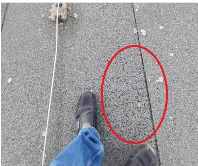
Obrázek č. 9 – popraskání SBS pásu vlivem stárnutí
