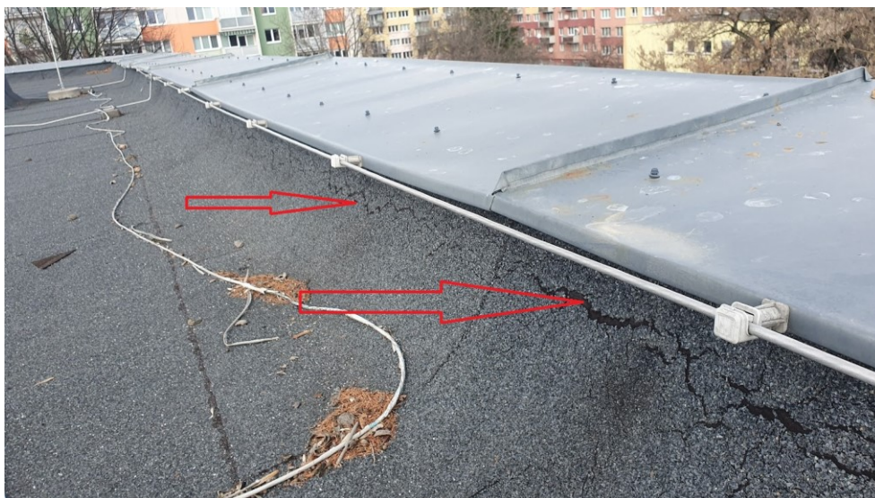
Obrázek č. 7 – Deformace lemů zdí SBS pásu
