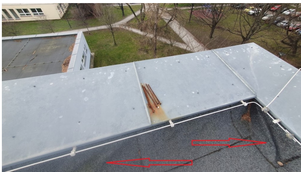
Obrázek č. 3 – deformace SBS pásu od atikové konstrukce
