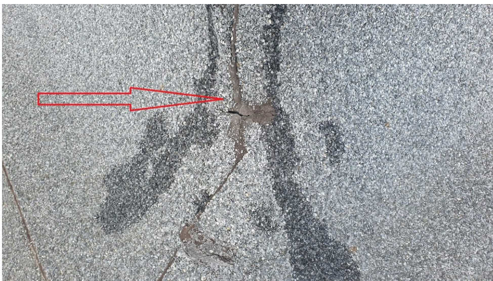
Obrázek č. 4 – nedokonalý nedolepený spoj SBS pásu
