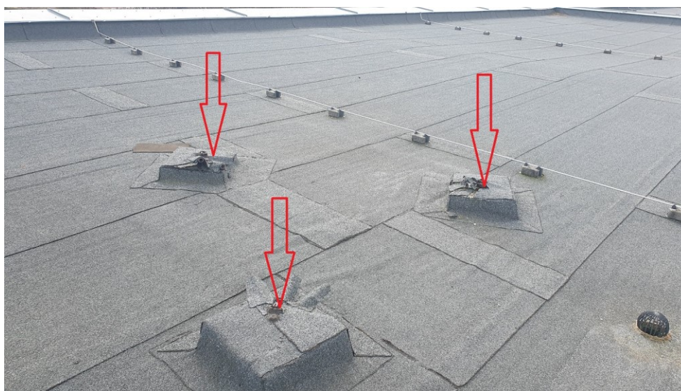
Obrázek č. 11 –kotevní základy bez provedení zakrytí hydroizolace
