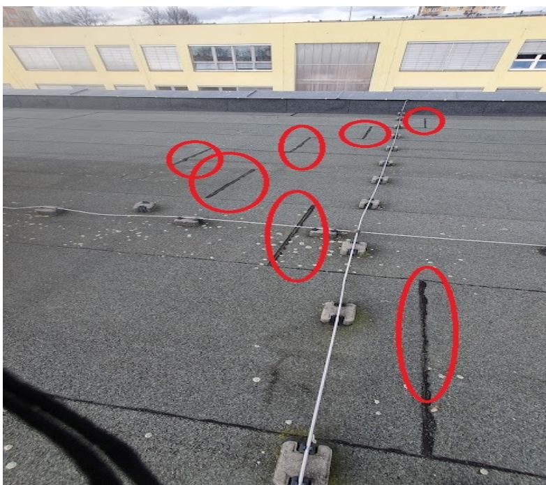
Obrázek č. 10 – deformační posuv SBS pásu vlivem nekvalitního pásu
