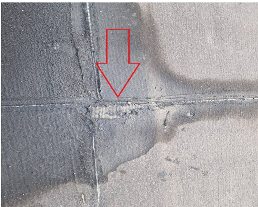
Obrázek č. 4 – detail oxidovaného pásu s degradací a obnaženou sklo vláknitou vložkou
