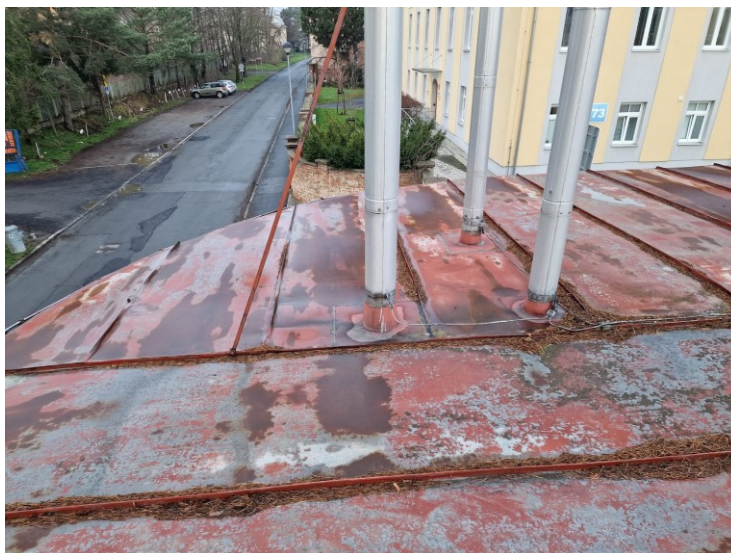
Obrázek č. 7 – Pohled na celkovou spodní střešní plochu- detail koroze
