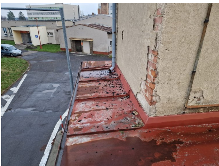
Obrázek č. 8 – Pohled na degradaci komínového tělesa
